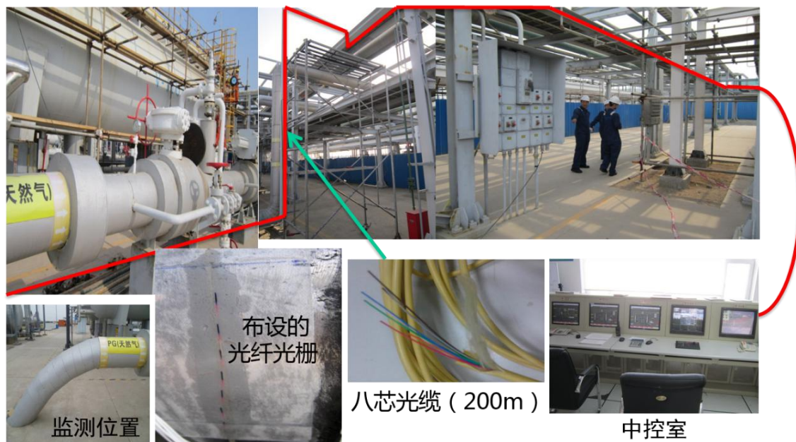
图 3: 中海油渤南龙口天然气终端处理厂现场实施图
